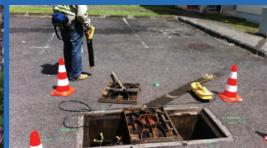
Pour répondre aux exigences de la réglementation DT-DICT, et pour réaliser des investigations complémentaires fiables, les opérateurs doivent absolument maîtriser la méthode électromagnétique.
